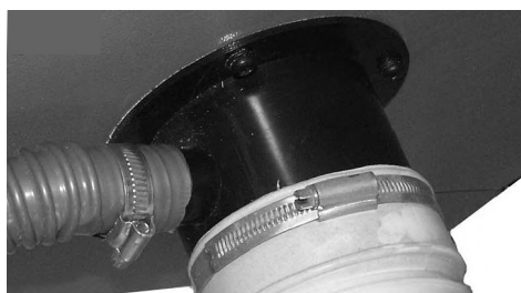
Obr. 18: Montáž odsávacích hadic
